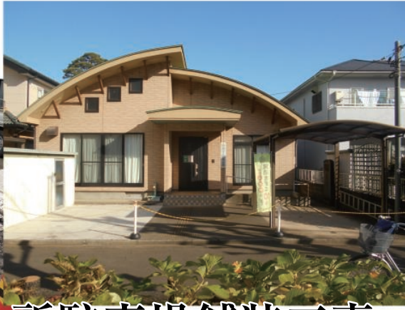
集会所駐車場舗装工事 5月16・17日
